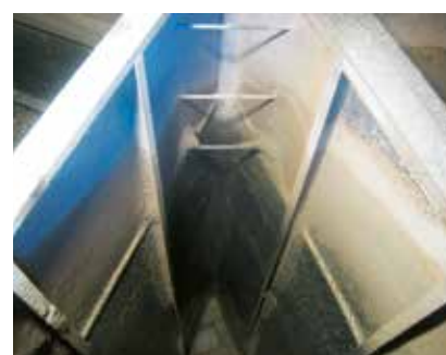
60 Shore rubber in een stortbunker
