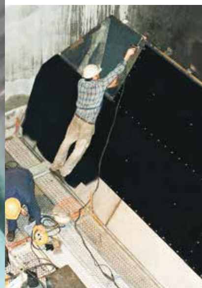
Het bekleden van een bunker met WearProtect PE
