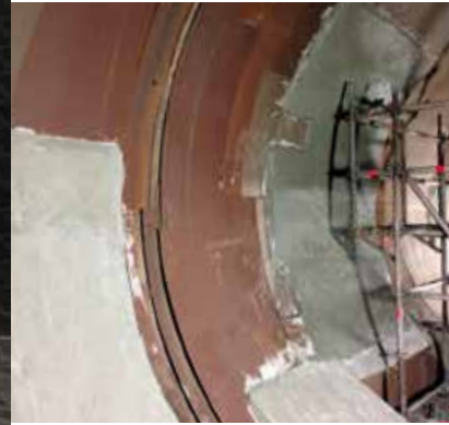
Reparatievlak bij een sinterfabriek
