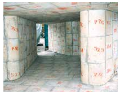
Kalcor platen in een rookgasreiniging installatie
